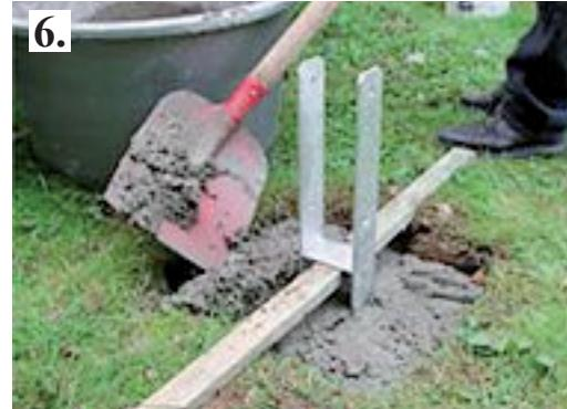
Füllen Sie Beton in das ausgegrabene Loch. Der H-Pfostenanker bleibt weiterhin mit der Leiste fixiert. Danach den Beton glattstreichen.
