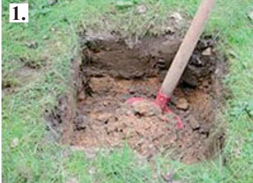
Eine Grube für jeden Pfosten ausheben.
