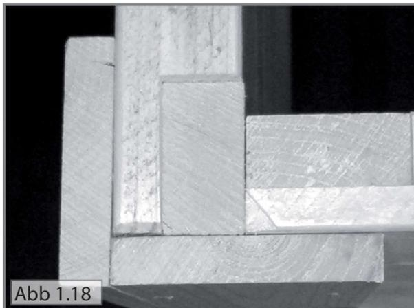
13. Nach der Montage der Türe befestigen Sie die Abdeckleisten. Beginnen Sie mit der vorderen Abdeckleiste links neben der Türe und befestigen danach die zweite Abdeckleiste über Eck. (Schrauben 3x40 - Abb.1.18)
