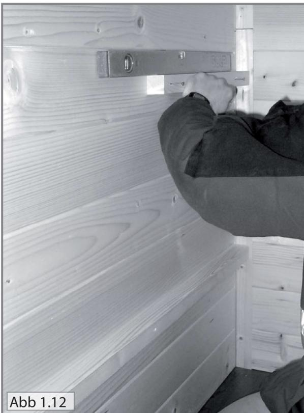
8. Montieren Sie jetzt die Bankauflageleisten. Die unteren 4x4x100 cm langen Bankauflageleisten befestigen Sie 41 cm vom Boden bis Oberkante Leiste an den beiden Seiten links und rechts der Glastüre. (Schrauben 4x70)
