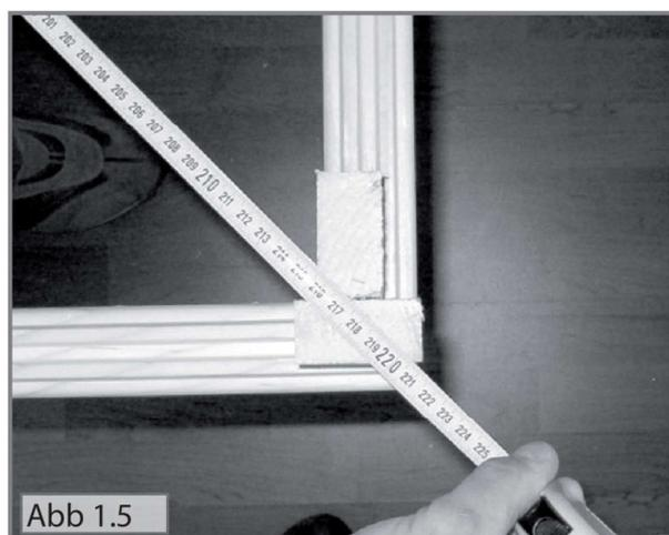
3. Kontrollieren Sie, ob die Saunakabine im rechten Winkel steht, indem Sie diagonal die Länge auf beiden Seiten messen. (Abb.1.5)
