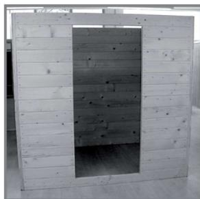
6. Als nächsten Schritt befestigen Sie die Dachauflageleisten 9,5 cm von Seitenoberkante bis Leistenunterkante an den Seiten. (Schrauben 4x70 - Abb.1.9) Die Rundung der Leisten sollte unten sichtbar sein.
