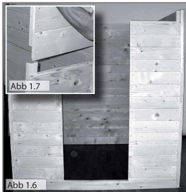
5. Legen Sie nun die oberste Blockbohle auf die vordere Seite und verschrauben diese mit den Seiten. (Schrauben 3x40 - Abb.1.8)
