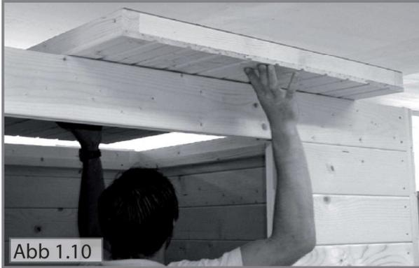
7. Sind alle vier Leisten montiert, können Sie die beiden Dachelemente auf die Leisten legen. (Abb.1.10 + Abb. 11) Danach verschrauben Sie die Dachteile von oben. (Schrauben 5x80)
