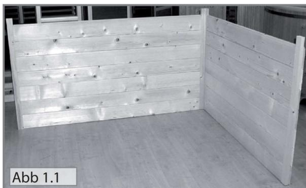
1. Zu Beginn stellen Sie die rechte Seite und die Rückwand (Teil I unten gerade) wie in Abb.1.1 so aneinander, dass die Schrauben außen sichtbar sind. Verschrauben Sie die Seite mit der Rückwand. (Schrauben 5x80) Verfahren Sie mit der linken Seite ebenso. Die Rückwand wird zwischen den beiden Außenseiten montiert.
