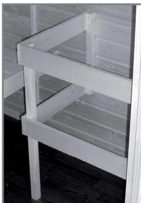
15. Jetzt ist Ihre Sauna schon fast fertig. Verschrauben Sie noch die einzelnen Leisten des Ofenschutzgitters wie in Abb.1.20 dargestellt. (Schrauben 3x40)
