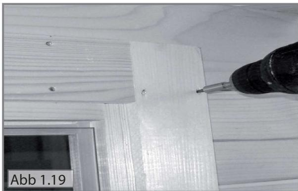
14. Befestigen Sie jetzt die inneren und äußeren Abdeckleisten an dem Türstock und an der Türseite. (Schrauben 3x40) Der Abstand zum Türrahmen beträgt ca.12 mm auf allen Seiten. (Abb.1.19)
