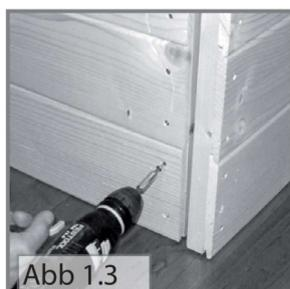
2. Nun nehmen Sie die vordere Blockbohle mit dem Ausschnitt für die Türe und stellen das schmale rechte Wandelement darauf. (Element hat rechts unten eine vorstehende Leiste. Abb.1.2) Verschrauben Sie jetzt die untere Blockbohle von vorne mit der Leiste (Schrauben 3x40 - Abb.1.3) und seitlich mit der Außenseite.
