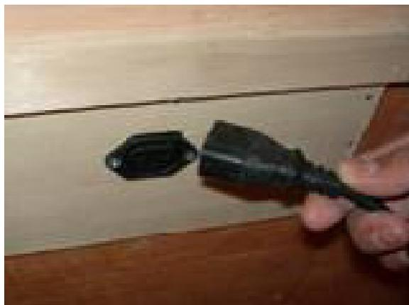
4. Das Deckenelement muß so positioniert werden, dass sich die Kabel in der vorderen linken Ecke befinden, direkt überm Radio. Führen Sie die Kabel der Heizung durch die entsprechenden Bohrungen im Deckenelement.
