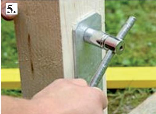
Die Schraube mit Mutter und 2 Unterlegscheiben fixieren.
