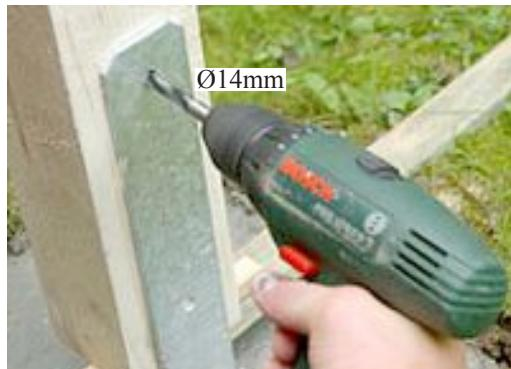
Das Holzprodukt aufstellen. Die Pfosten in die H-Pfostenanker stellen. Etwas Abstand zwischen Pfostenende und Metall lassen. Die Pfosten durchbohren um sie mit den H-Pfostenankern zu verschrauben.
