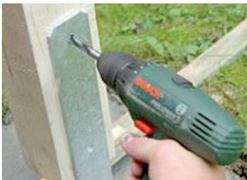
Das Holzprodukt aufstellen. Die Pfosten in die H-Pfostenanker stellen. Etwas Abstand zwischen Pfostenende und Metall lassen. Die Pfosten durchbohren um sie mit den H-Pfostenankern zu verschrauben.
