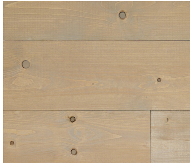
Wand im Bereich der Astlöcher farbig gestaltet
