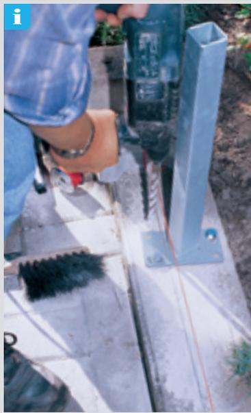
**i** ! Hier ist die Befestigung mit einem herkömmlichen Kunststoffdübel dargestellt. Ihr Fachhändler hält auch gesondert Spezialdübel, z.B. Klebedübel oder Schwerlastanker, bereit
